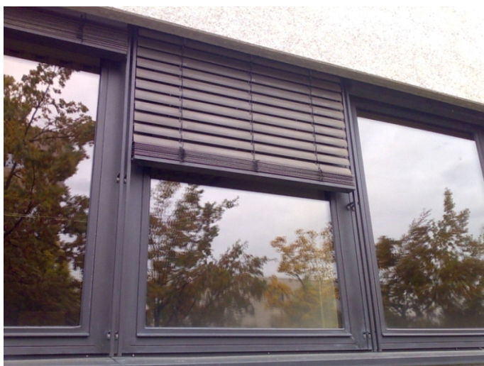
ภาพที่ 5-22 การใช้อุปกรณ์กันแดดแบบ Shutter ภายนอกอาคาร ซึ่งมีประสิทธิภาพสูง เพราะสามารถกันความร้อนตั้งแต่ก่อนเข้าสู่อาคาร
