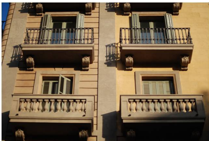
ภาพที่ 5-21 การใช้อุปกรณ์กันแดดด้วย shutter ที่มีประสิทธิภาพสูง ในบ้านแบบโบราณ
